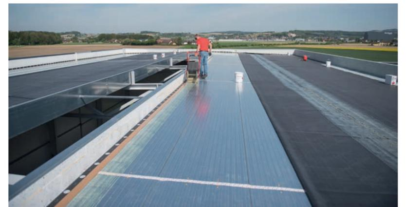
„Kautschukbahnen zeichnen sich durch hohe chemische Verträglichkeit gegenüber üblicherweise in Verbindung stehenden Baustoffen aus. Die hohe Verformbarkeit, ohne dass das Material Schäden durch Bruch, Risse u. dgl. erfährt, ist ein wesentlicher Vorteil. Das bedeutet, dass nach einer Belastung z.B. durch Begehen bei Sonneneinstrahlung auf der meist schwarzen Abdichtungsbahnenoberfläche das Material wieder in seine Ausgangsform zurückkehrt.“
